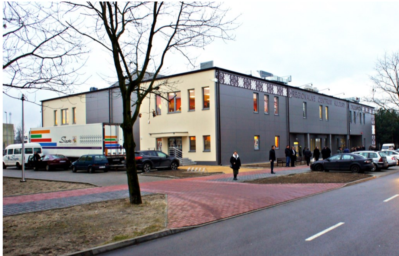
Zdjęcie budynku – widok zewnętrzny
