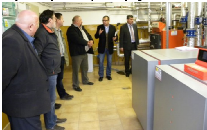
Komisja odbierająca zainstalowane pompy ciepła
