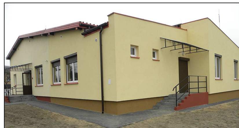
Przebudowany i rozbudowany budynek strażnicy OSP Domaszno
