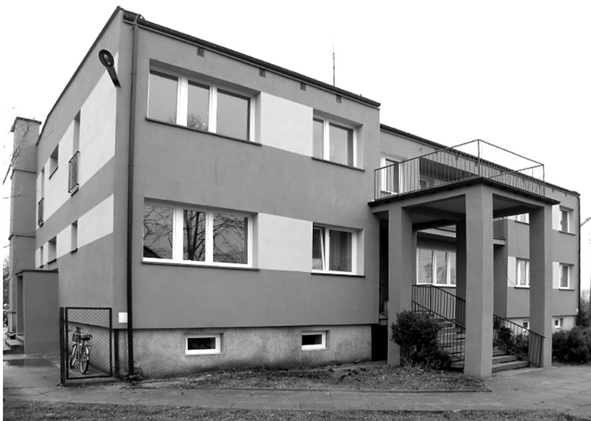
Budynek Ośrodka Zdrowia w Radzicach Dużych po remoncie
