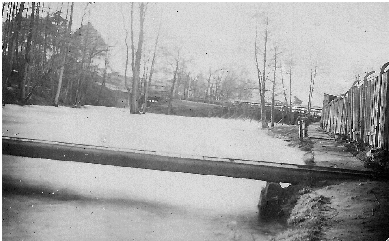
Drewniany mostek kolejki szynowej przerzucony nad korytem Drzewiczki prowadzący ze Skały do fabryki. Zdjęcie z lat czterdziestych XX w.
