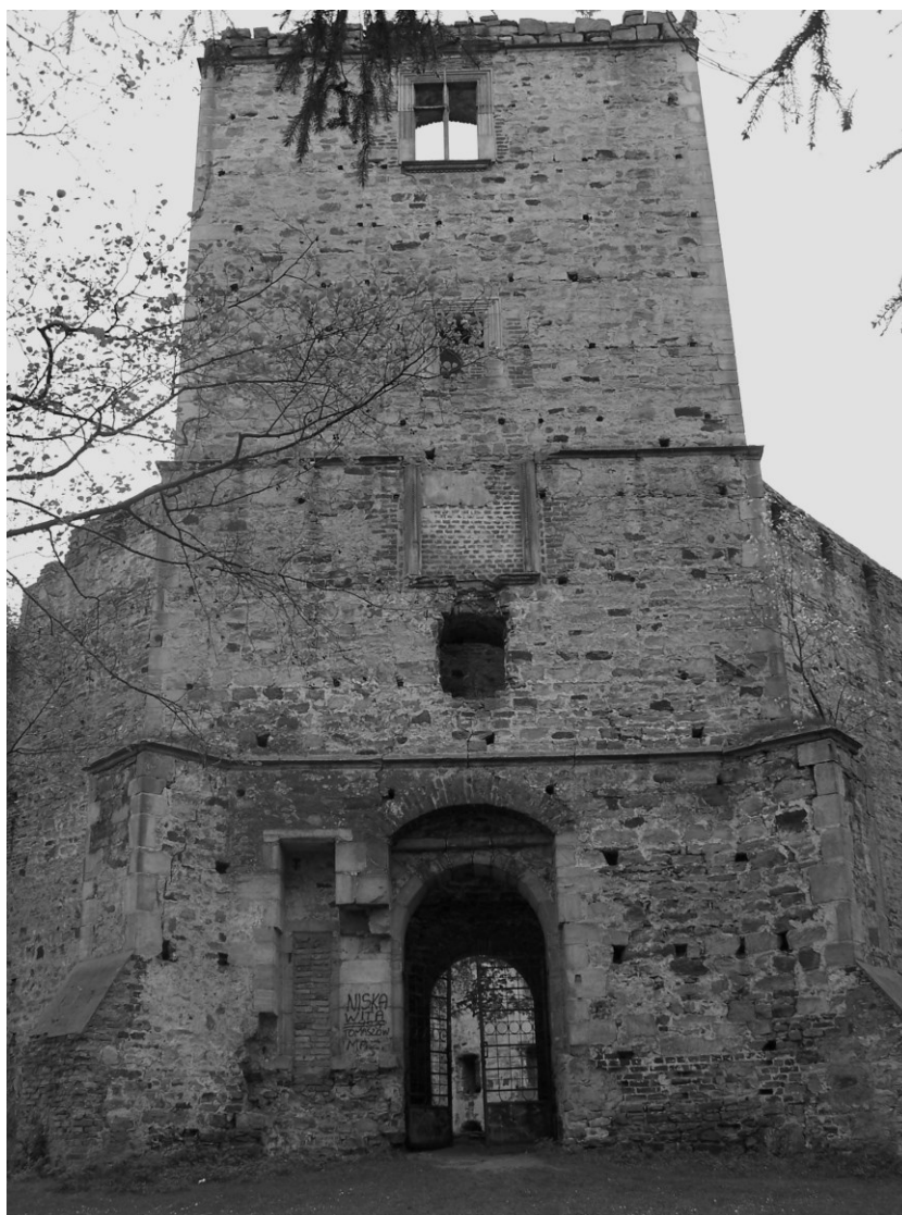
Baszta z bramą wjazdową i wejściem dla pieszych. U góry zasklepione okno to tablica erekcyjna, na której był wymalowany herb i nazwisko fundatorów.
