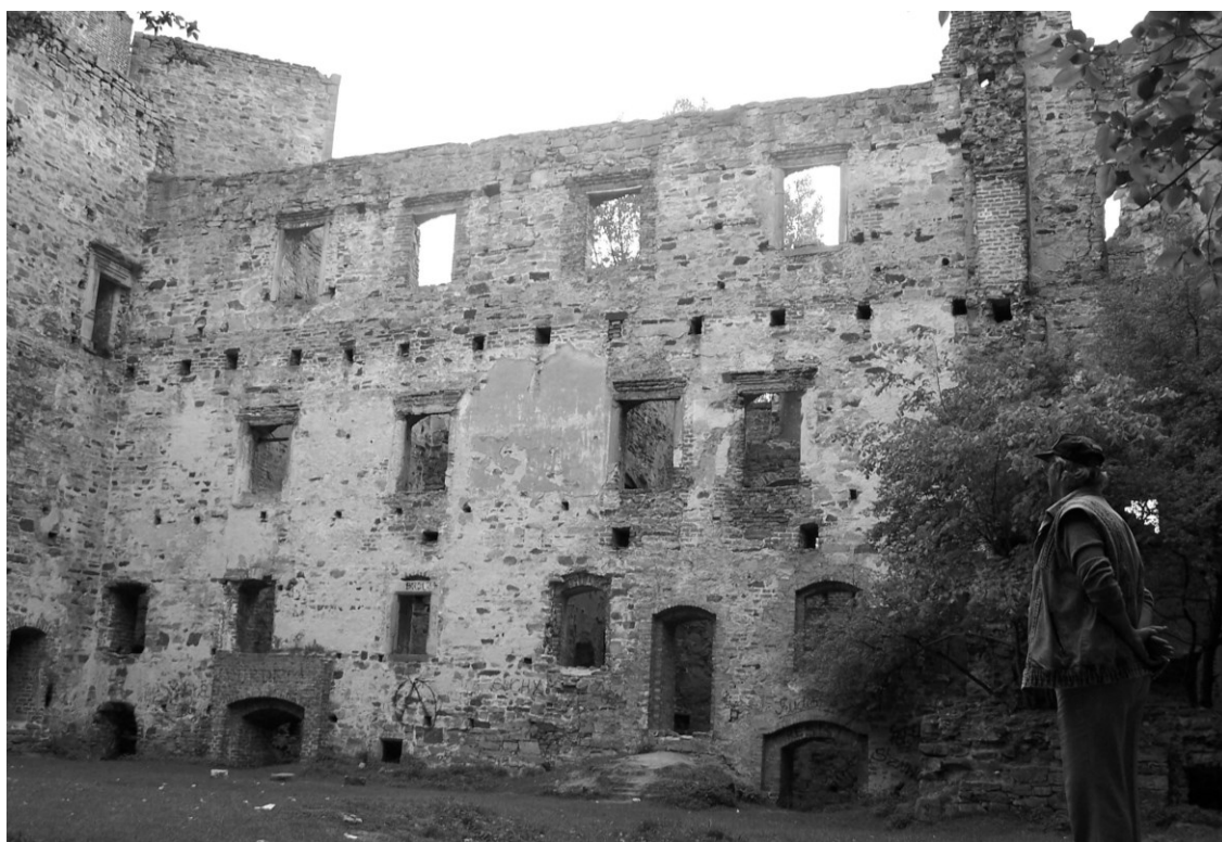
Widok na pałac zamkowy. U góry – otwory po belkach powstrzymujących krużganek. Na dole – widoczne trzy wejścia do piwnic zamkowych.
