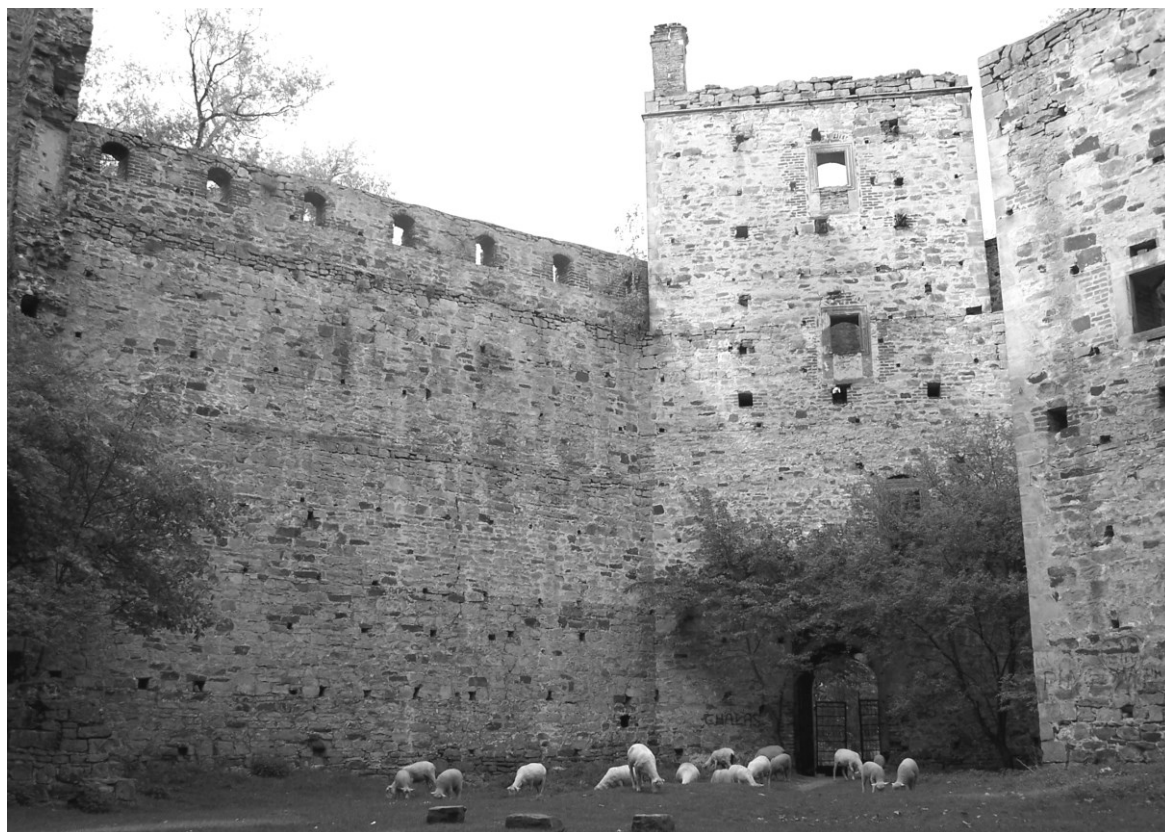
Tzw. kurtyna 12-metrowej wysokości z otworami strzelniczymi. W bramie wejściowej widoczne szczątki wspornikowych bali balkonowych.
