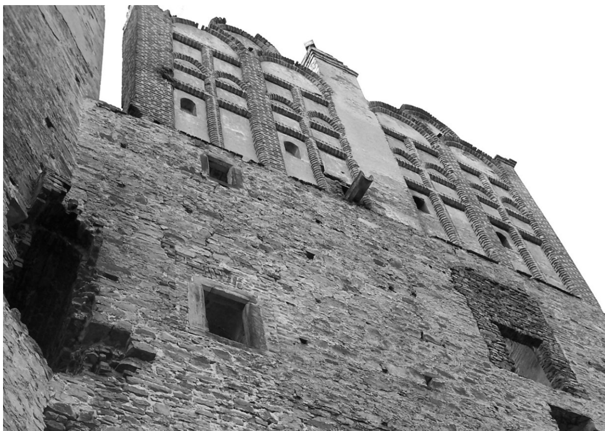
Mur szczytowy od strony południowej. Widoczna wystająca z niego rynna kamienna – tzw. rzygacz. Po prawej stronie zamurowane wielkie okno dawnej kaplicy zamkowej. Z lewej strony otwór po zburzonej latrynie.
