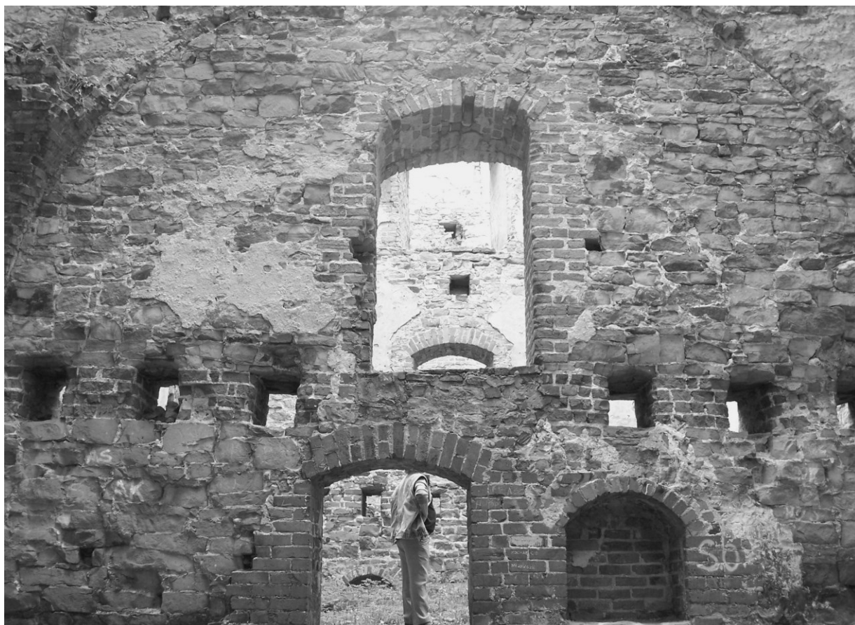
Piwnica zamkowa od strony południowej. W murze widoczne otwory po belkach stropowych. U góry: pomieszczenie mieszkalne o sklepieniu kolebkowo-krzyżowym z przejściem do następnej komnaty.
