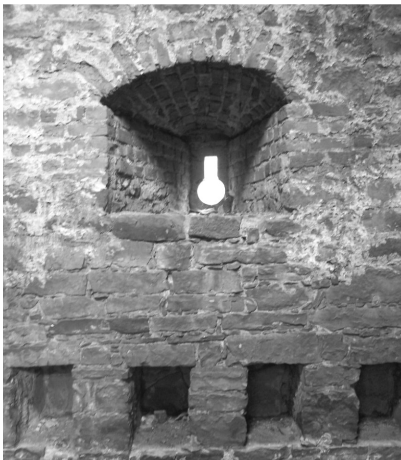
Wnęka działobitni z otworem strzelniczym, tzw. „dziurka od klucza” w wieży południowo-wschodniej. U dołu – otwory po potężnych belkach stropowych.
