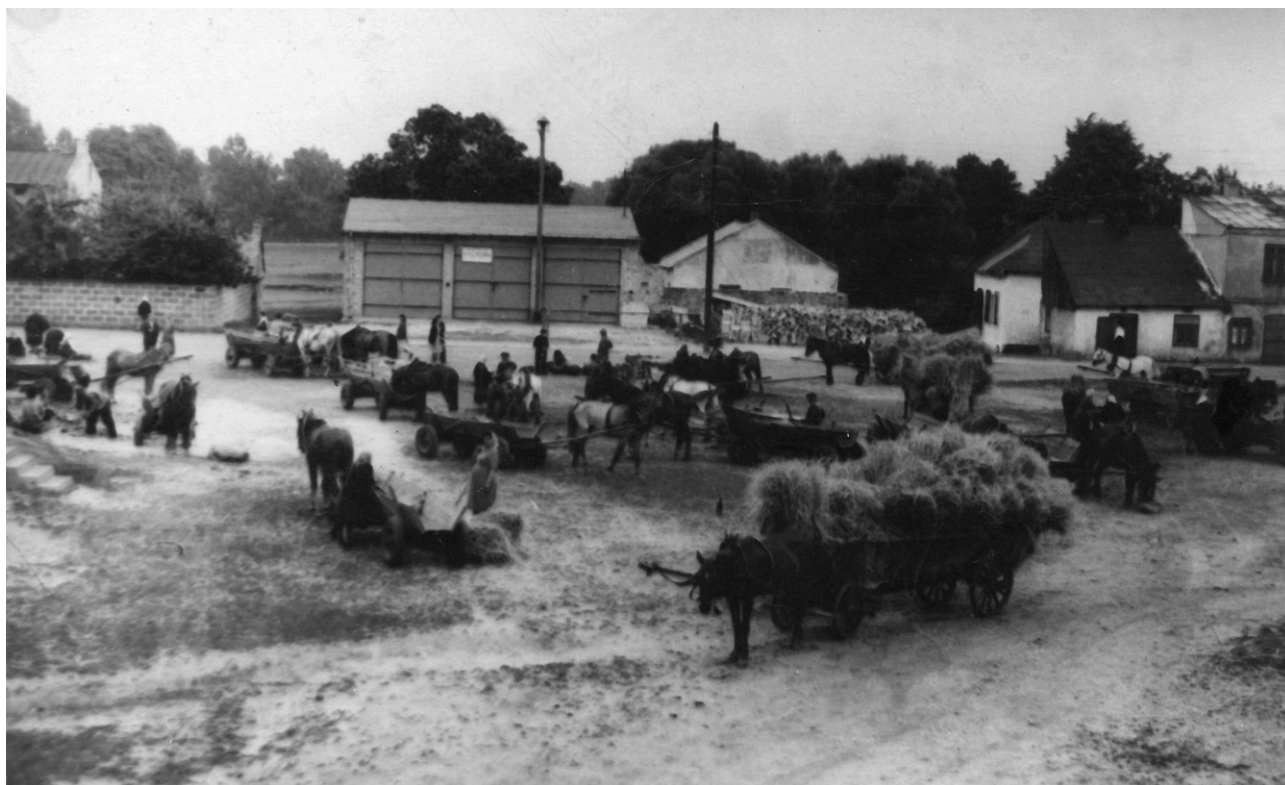
Ukończona 1. połowa remizy strażackiej – rok 1963. Na pierwszym planie targowisko na Placu Narutowicza
