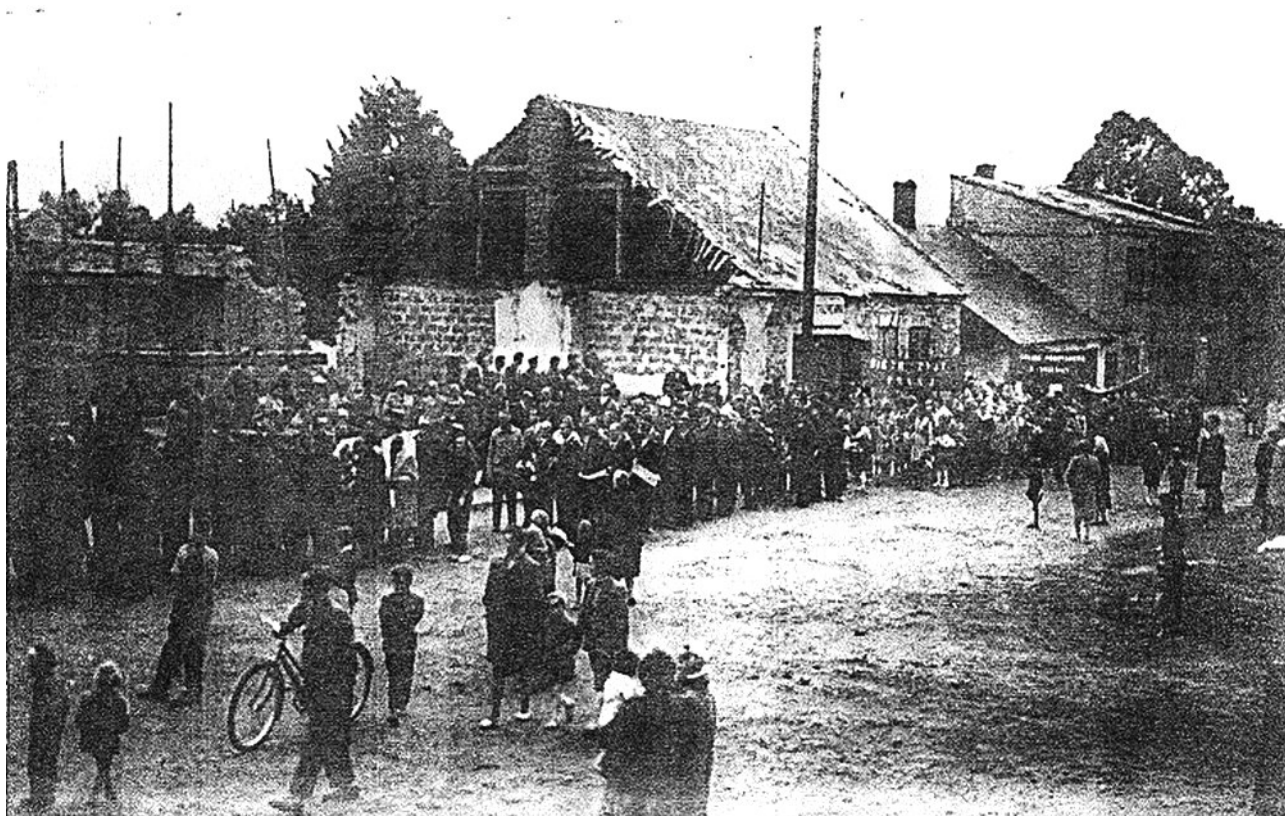
Rozpoczęcie budowy pierwszej połowy remizy strażackiej w 1960 r. Po prawej stronie widoczna część bożnicy zajmowana przez OSP Drzewica
