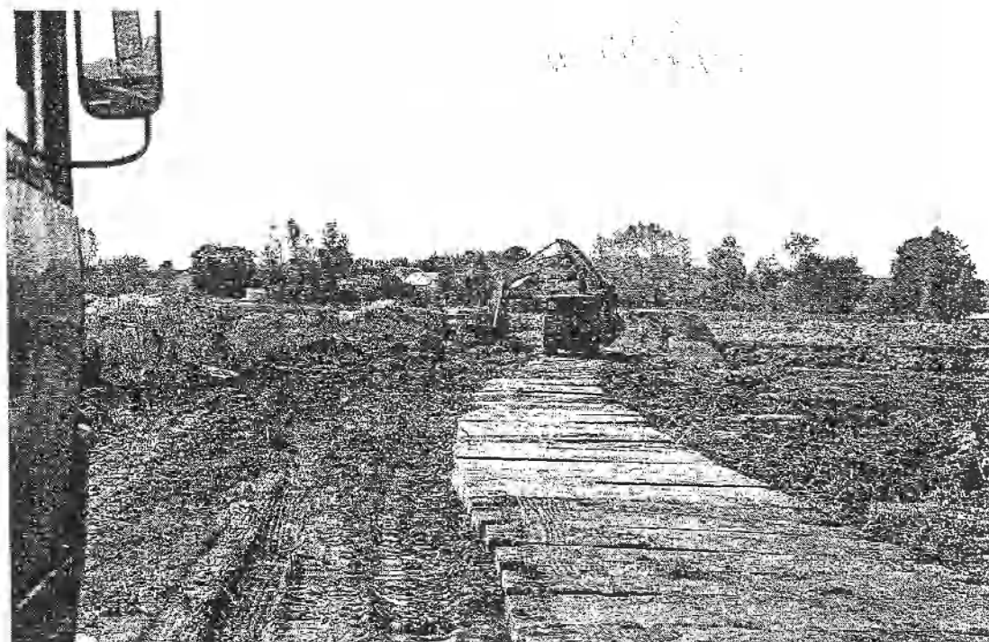
Ułożona droga z płyt betonowych służąca do wywozu ziemi i zanieczyszczeń z dna stawu (foto L. Milczarek)
