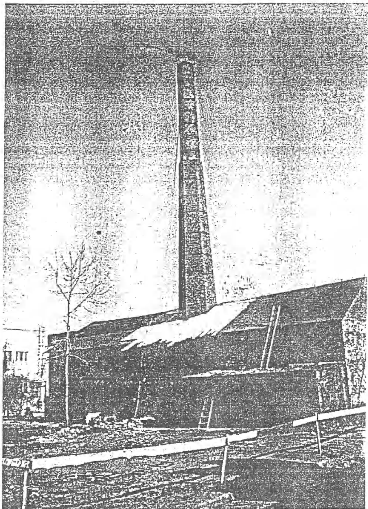
Zdjęcie wyżarzalni i komina, który rozebrano w 1985 roku. Tu komin w czasie rozbiórki.
