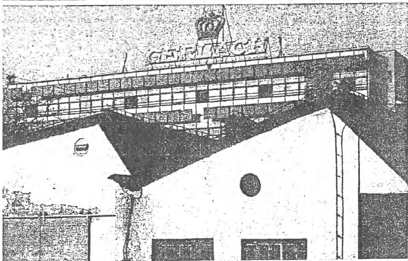
Na zdjęciu u góry: istniejąca jeszcze "najnowsza hala", w której mieściła się zyletkarnia, osadzalnia, nożyczkarnia i szlifiernia. U dołu: na pierwszym planie tzw. „polerownia mała”. W tle zdemontowane logo firmy „Gerlach”, które było umieszczone na dachu działu konstrukcyjnego w latach 80.
